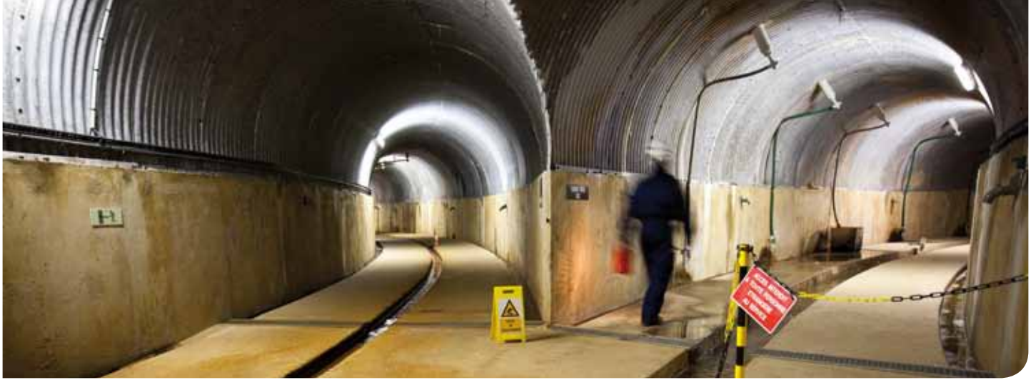
L'équipe d'exploitation a en charge le contrôle régulier des galeries et des équipements.
